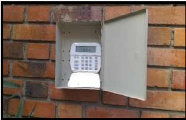
Dispositivo para activación de alarma monitoreada
